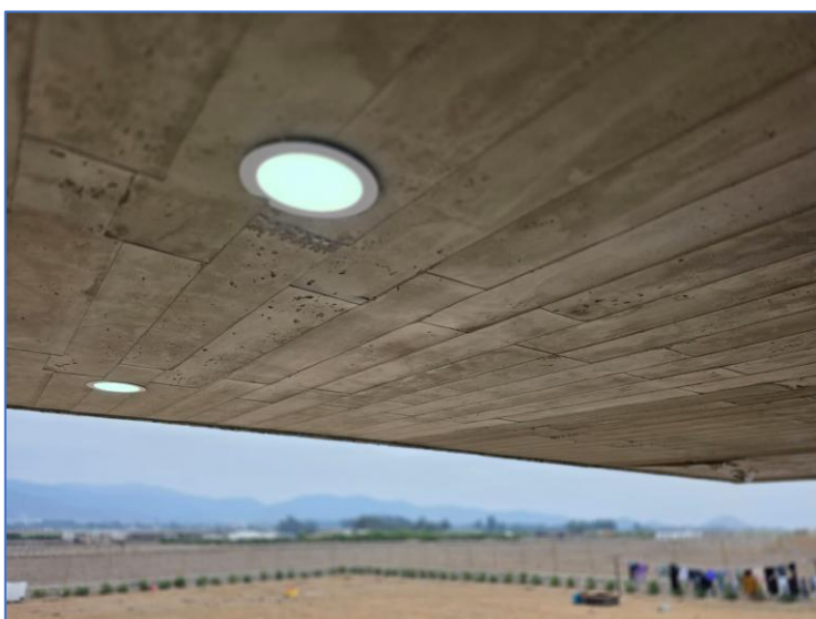
Técnica Hormigón Tableado
